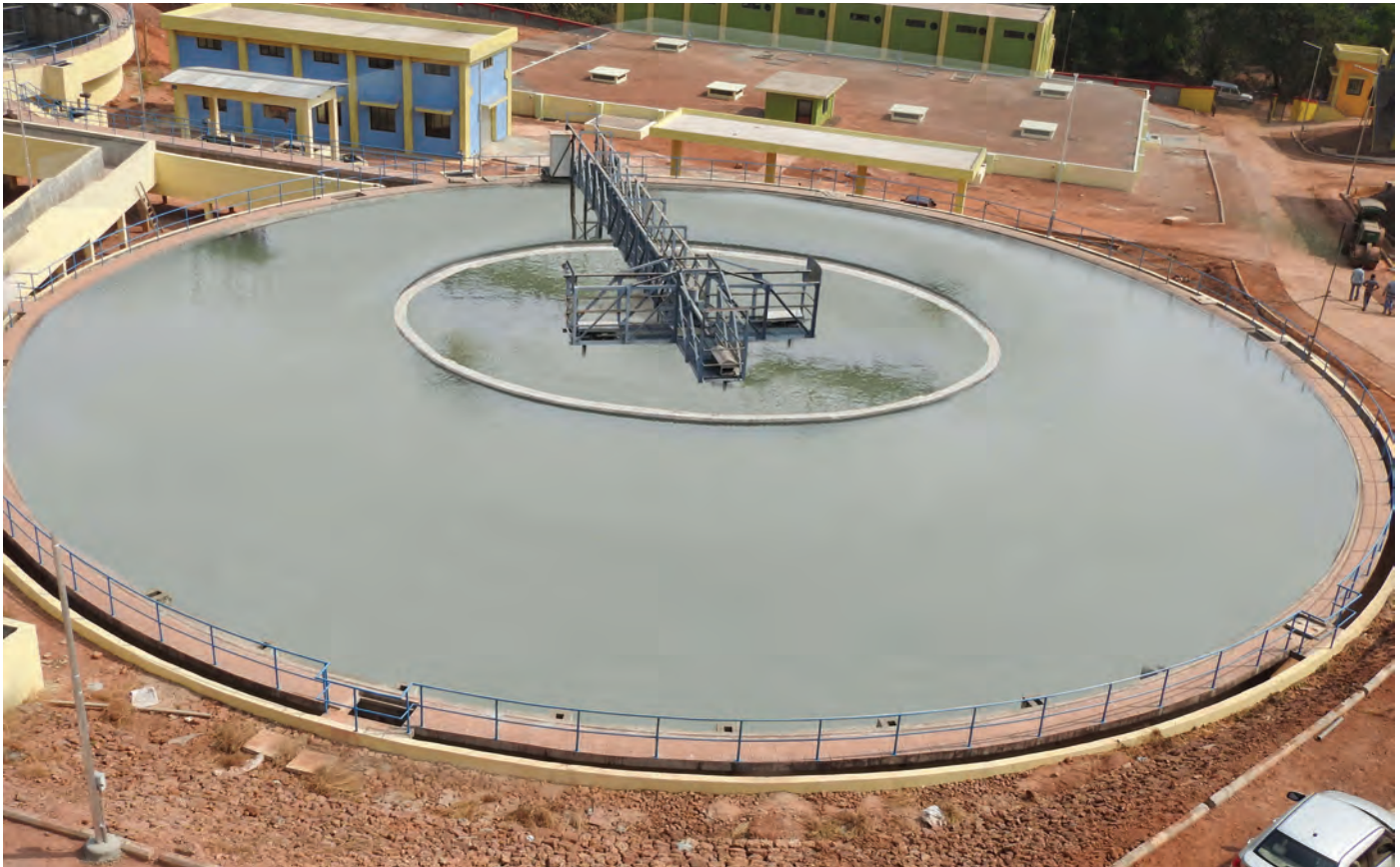
100 MLD WTP, Goa
