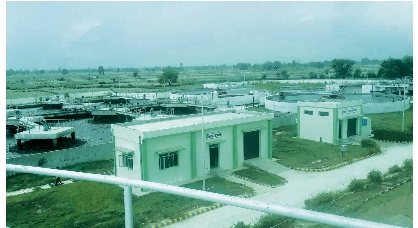
42 MLD STP, Kanpur
