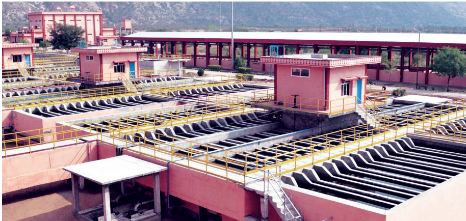
200 MLD WTP, Surajpura
